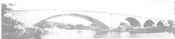
Puente "Almendares" construido en la gran fábrica de Cemento "El Almendares".
